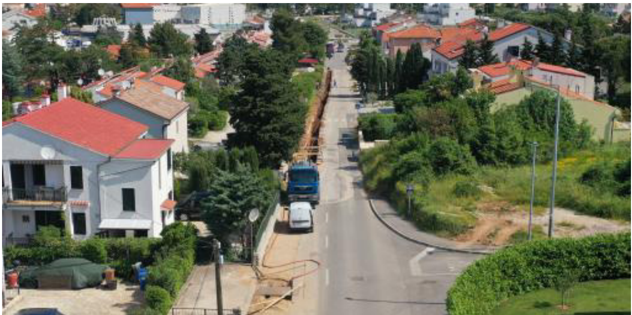
Slika 8 – pogled iz smjera Stare Baške na stacionažu cca km 3+800 prema km 3+500
