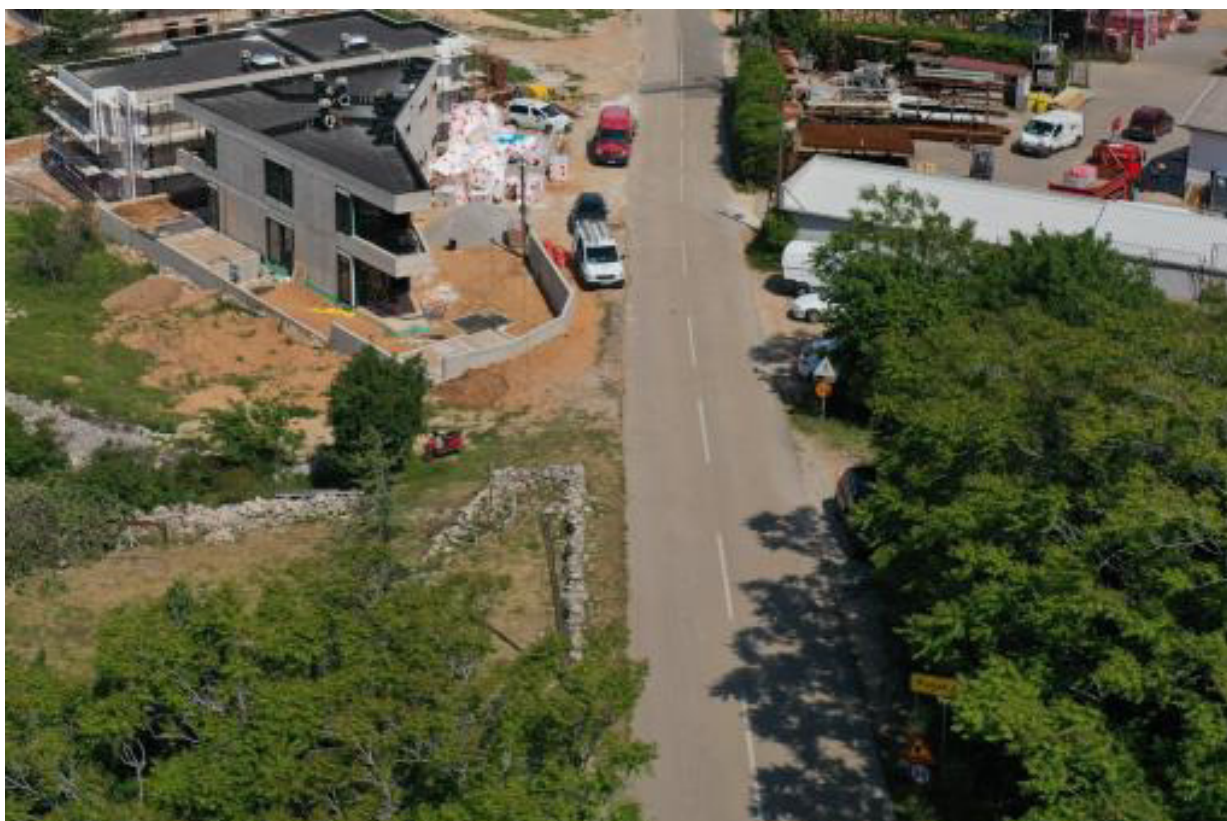
Slika 11 – pogled iz smjera Stare Baške na stacionažu cca km 4+585
