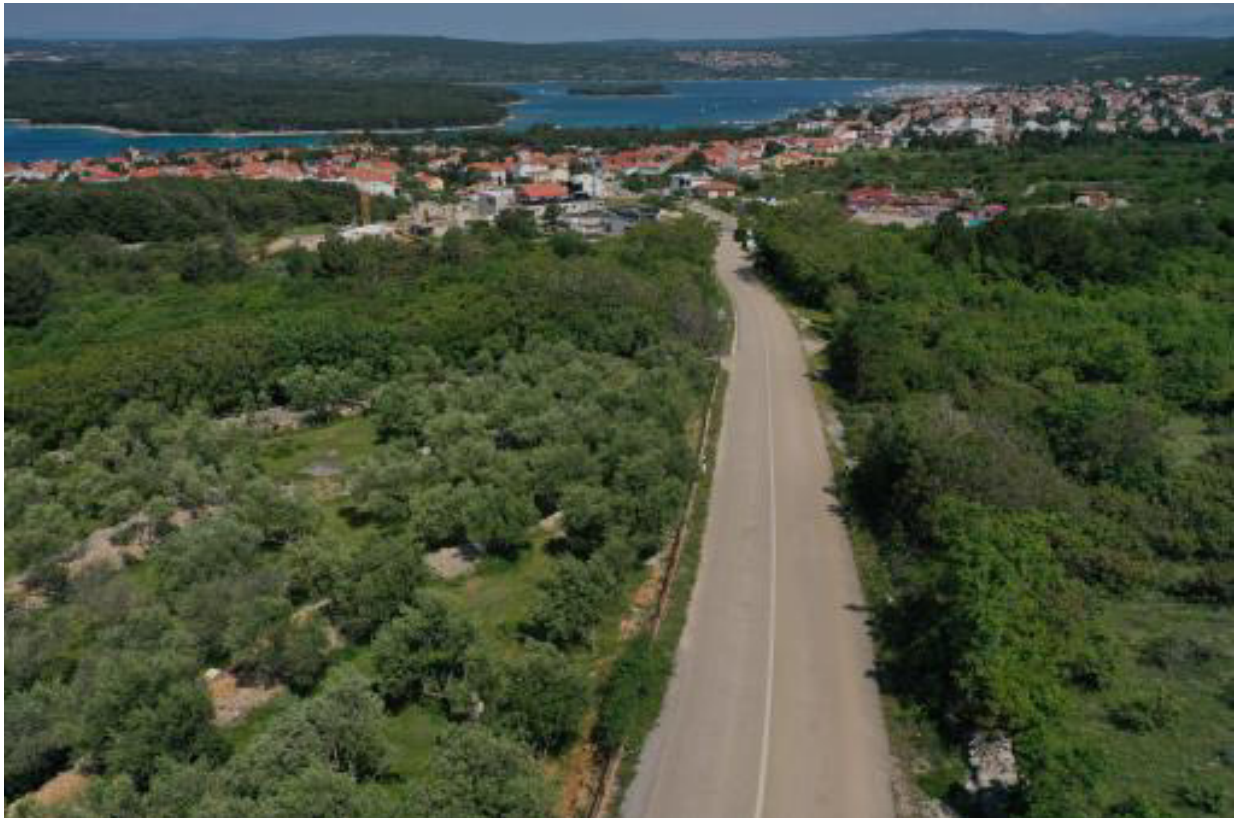
Slika 9 – pogled iz smjera Stare Baške na stacionažu cca km 4+700 prema km 4+300
