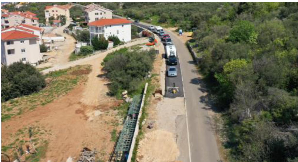
Slika 5 – pogled na dionicu iz smjera Stare Baške, betonirani prilaz vidljiv na zavoju, stacionaža cca km 3+000
