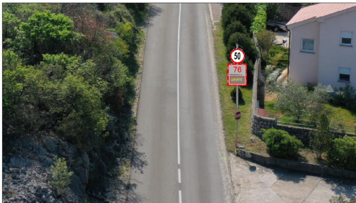
Slika 17. - Postavljanja preventivnog radarskog mjerača brzine Lokacija 1, stacionaža cca km 2+276 desno
