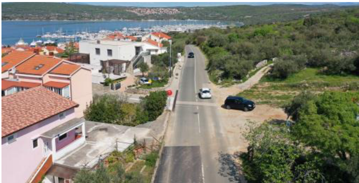
Slika 2 – pogled na dionicu iz smjera Stare Baške, raskrižje s ulicom Prgon, stacionaža cca km 2+420
