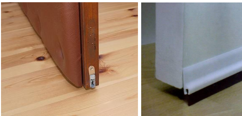
Ilustracija 59 – Spuštajuća brtva za vrata (lijevo) i četka za vrata (kao zaštita od prodora hladnoće, desno)
