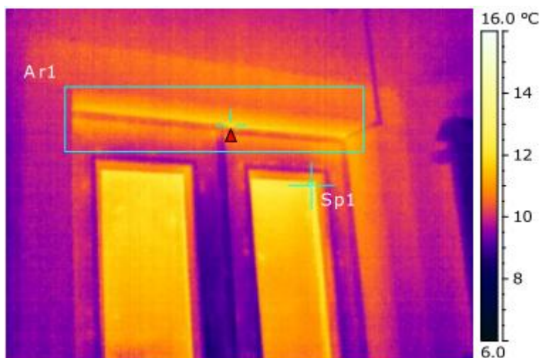
Ilustracija 55 – Termografska slika VI vanjske fasade upravne zgrade Općine Dobrinj 64
