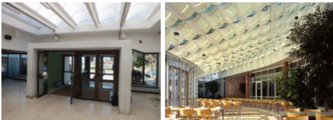
Ilustracija 46 – Aula škole u Omišlju i zasjenjivanje nadsvjetla na primjeru
