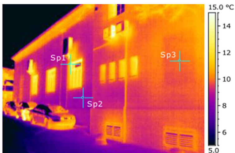
Ilustracija 64 – Termografska snimka III vanjske fasade Upravne zgrade Općine Puntar 71
