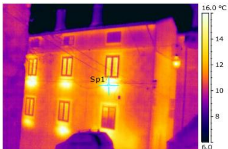
Ilustracija 50 – Termografska snimka I vanjske fasade upravne zgrade općine Dobrinj 59
