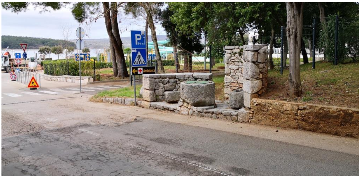
Slika 2. Postojeće stanje – kameni bunar u ulici Pod topol
